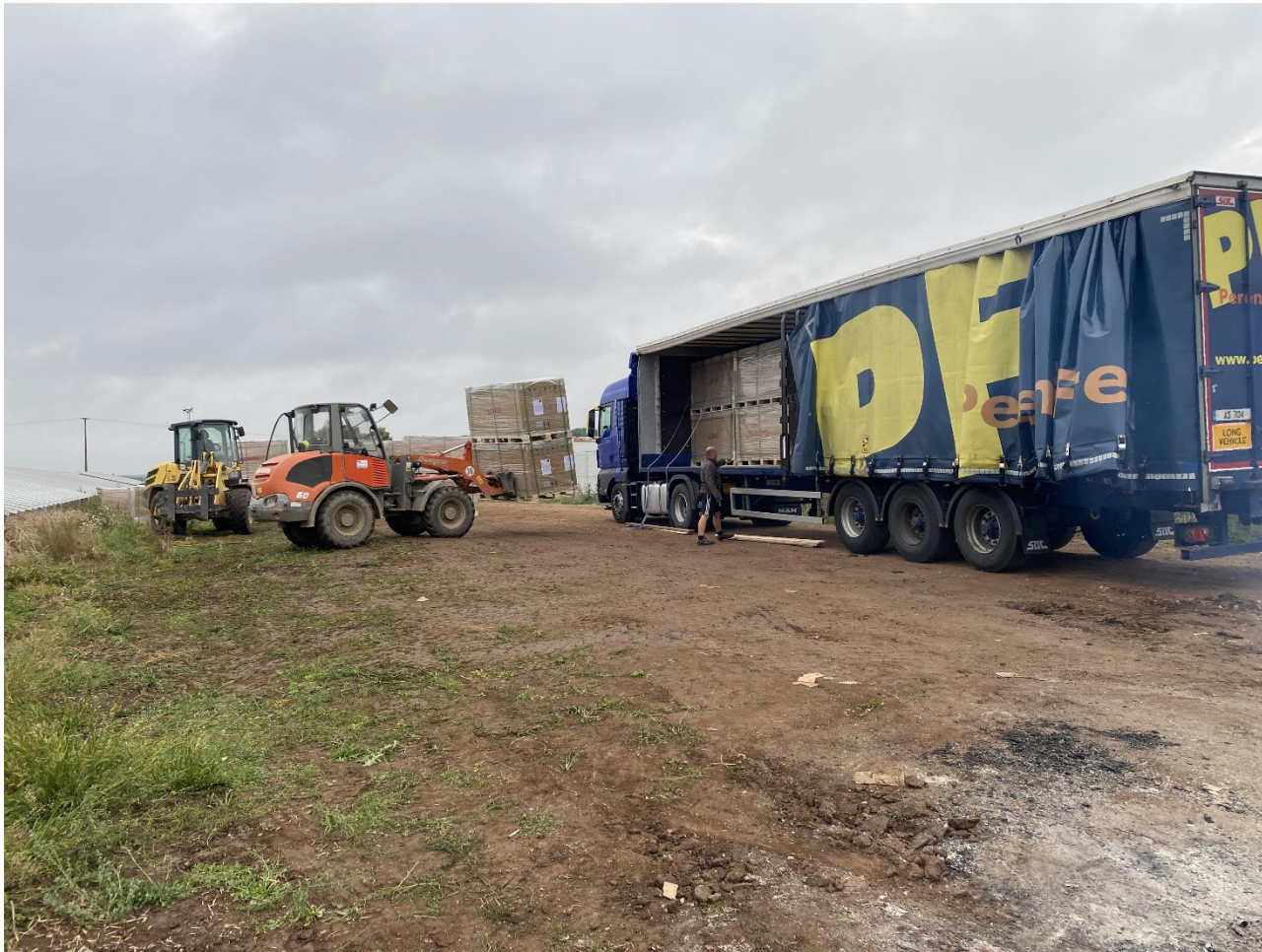
Déchargement des modules – source EnergieKontor
