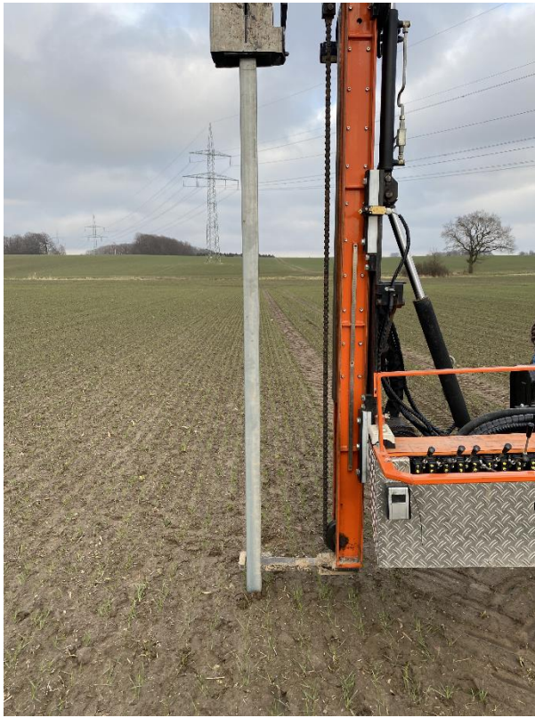
Battage des pieux – source EnergieKontor
