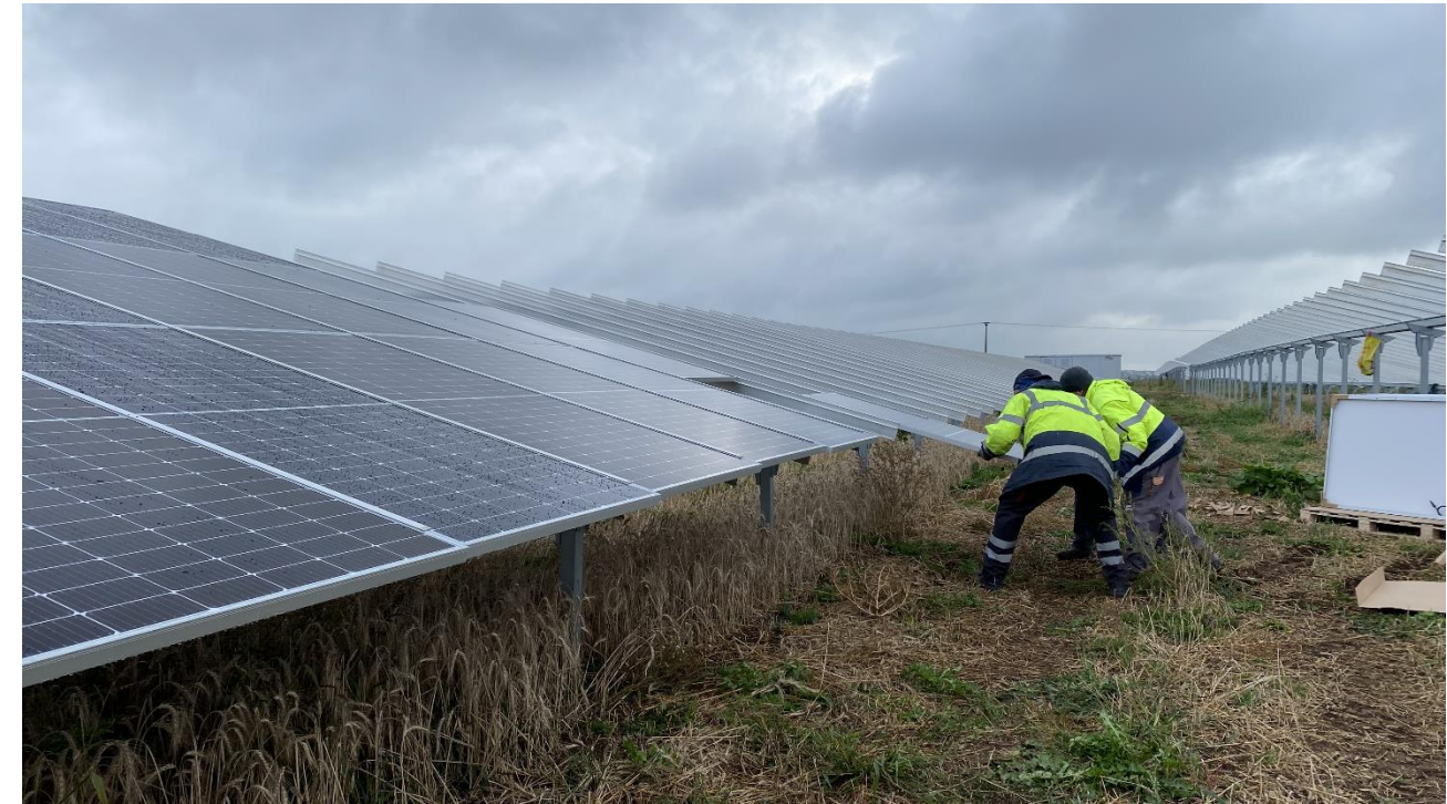
Mise en place des modules sur les structures – source EnergieKontor
